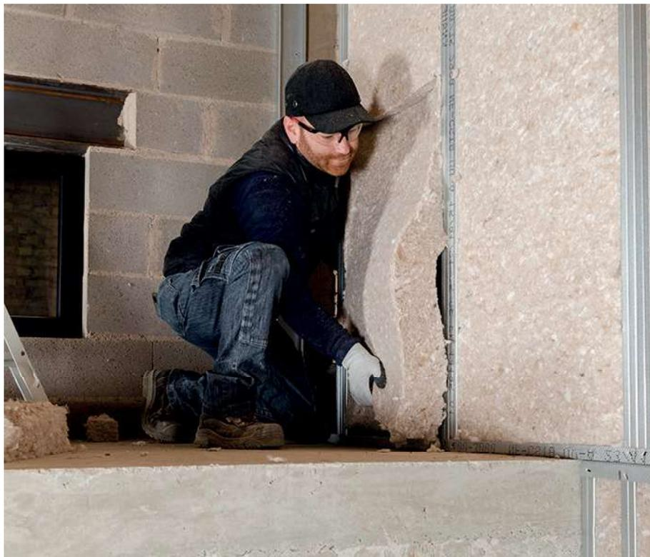
L'aspect doux et semi-flexible des panneaux Knauf ThermaSoft natura permet une mise en œuvre facile et agréable, notamment au toucher. Le panneau ne se délite pas et dégage peu de fibres textiles pendant sa découpe et sa manipulation, gage d'un chantier propre.
