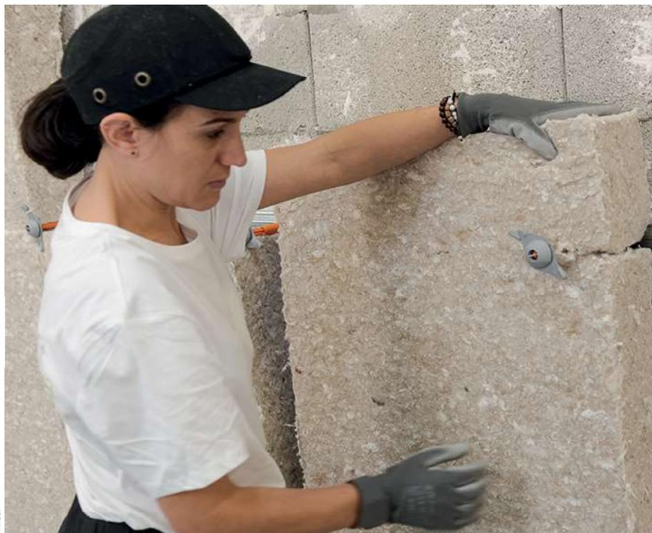
Le format 1 250 x 600 mm permet d'accompagner les entraxes habituels de 600 mm en aménagement intérieur, ainsi que de réaliser une hauteur d'isolation de 2,5 m (hauteur d'étage standard en rénovation) avec simplement deux panneaux, sans découpe ou ajout.
